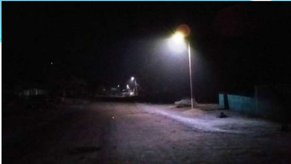
Капітальний ремонт мережі вуличного освітлення (Арбузинка, с. Новокрасне) – 1млн. 413,461 тис. грн.
